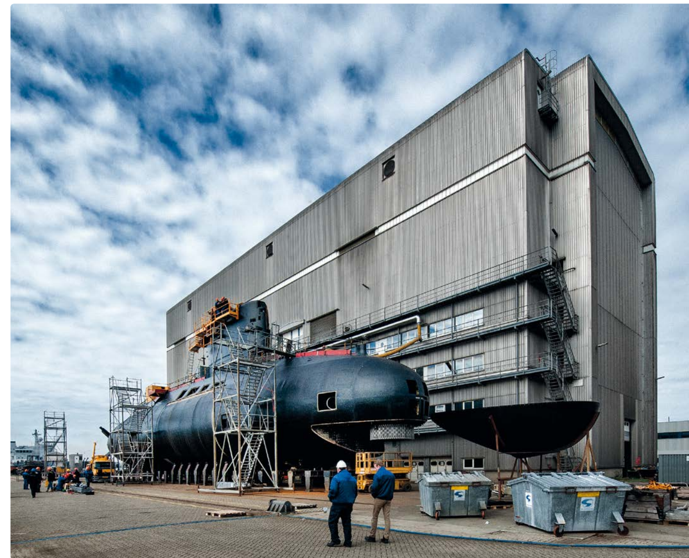
Het instandhoudingsprogramma (IP) zorgt voor een nieuwe manier van werken. Daar moet de bemanning zich goed op voorbereiden.
