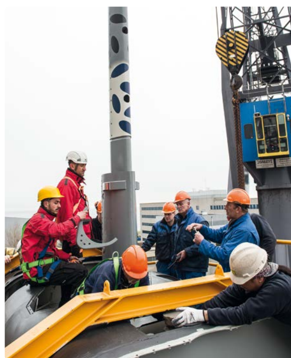
Monteurs leggen de laatste hand aan de nieuw geplaatste mast.
