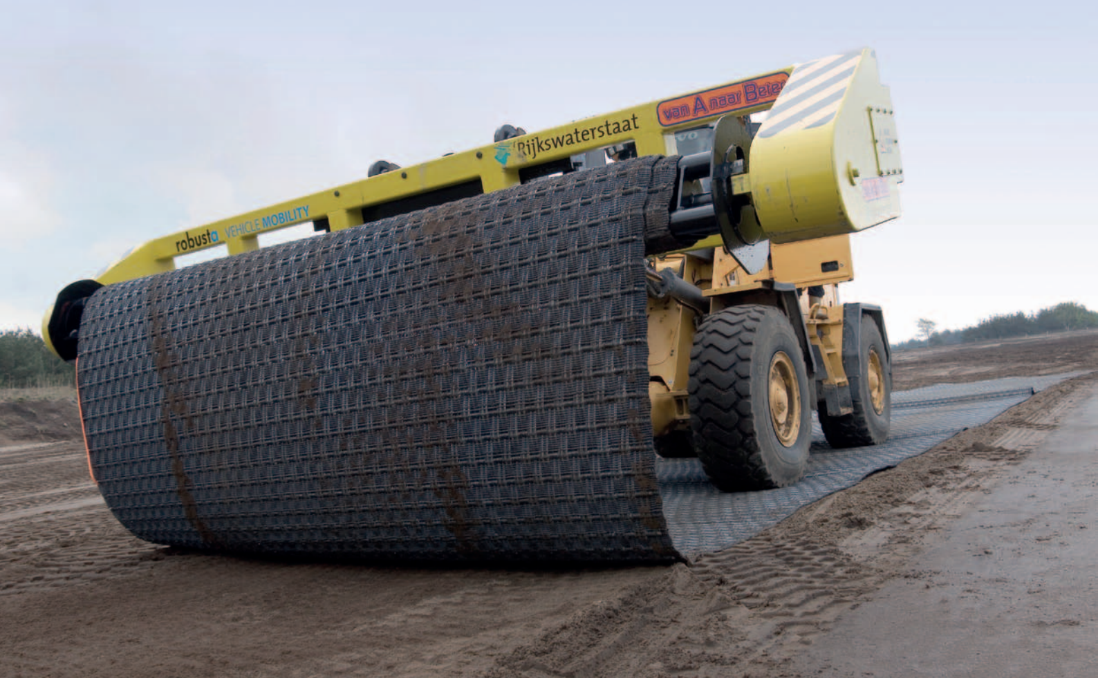
Het aanleggen van een verkeersomleiding bij calamiteiten is kinderspel met de Robusta Heavy Trackway. (Foto: Robusta)
